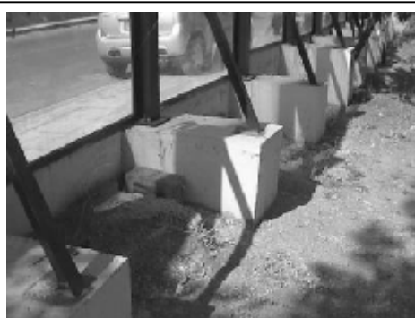
Προεξέχουσες αντηρίδες και σκυροδετημένες βάσεις εντός της αυλής σχολείου
