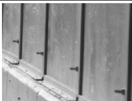
Όψη από την εξωτερική πλευρά της αυλής σχολείου (κοχλίες μεγαλύτεροι κατά 4cm), επί πλέον να προσεχθεί η ζητούμενη στην διακήρυξη «διαφάνεια»
