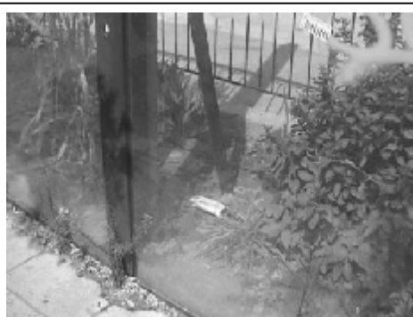
κάλυψη της σκυροδετημένης βάσης με χώμα κήπου και απ' ευθείας «φύτευση» της αντηρίδας, χωρίς πρόσθετη αντισεισμική επεξεργασία
