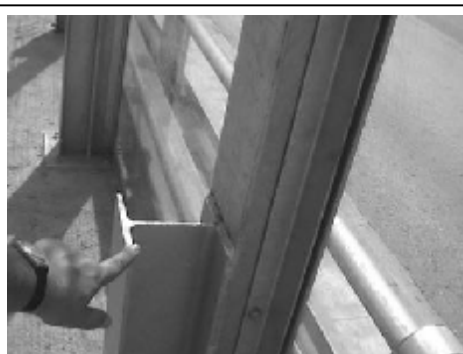
Ατρόχιστες και κοφτερές ακμές σε στάθμη προσιτή από μαθητές και πεζούς (-90cm από πεζοδρόμιο)
