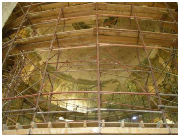
Εικόνα 3.4 Οι σκαλωσιές περιμετρικά στον χώρο, το 2008
