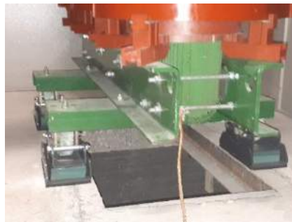
Σχήμα 4.2. Λεπτομέρεια εφαρμογής τεσσάρων αντικραδασμικών πελμάτων στη βάση του μετασχηματιστή.
