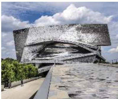
Σχήμα 3.7 Αποψη του κτιρίου [2]
