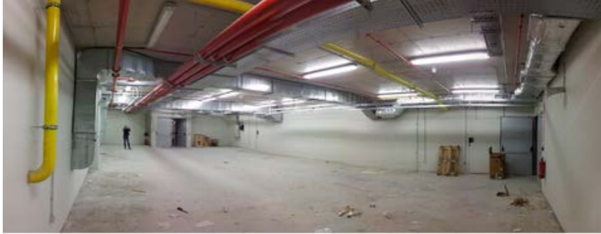
Εικόνα 1.1. Όψη της αρχικής κατάστασης του χώρου [Πηγή: ΜΕΤΕ ΣΥΣΜ].
