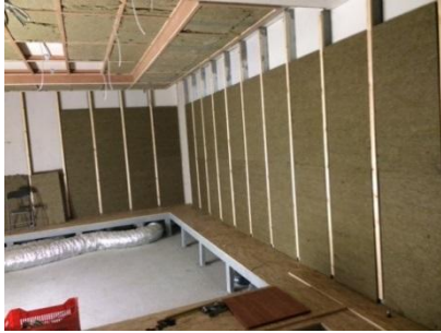
Ο θάλαμος κατά την κατασκευή
